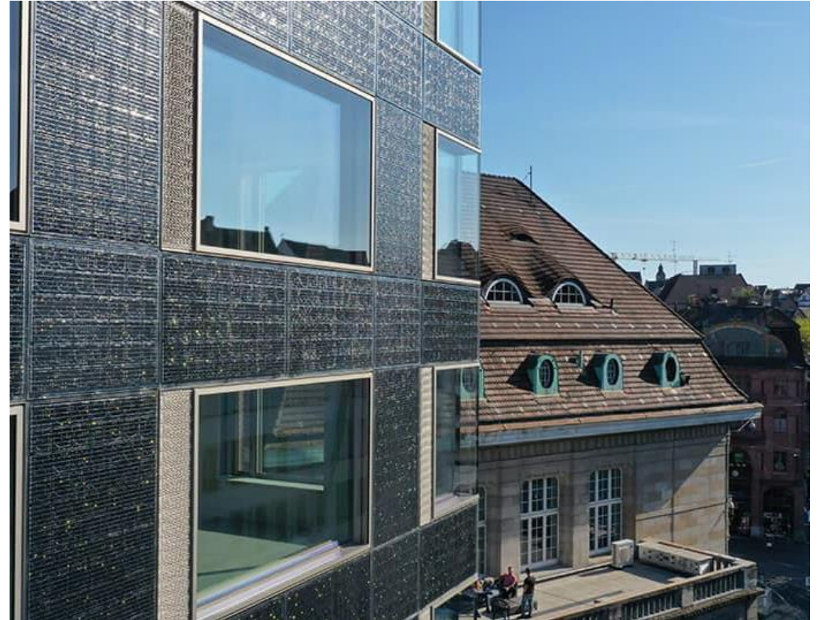
Die Photovoltaik-Fassade erstreckt sich über 1140 Quadratmeter der Gebäudehülle. Foto: Megasol Energie AG
